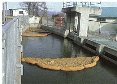
農業用水路への油流出処理例
