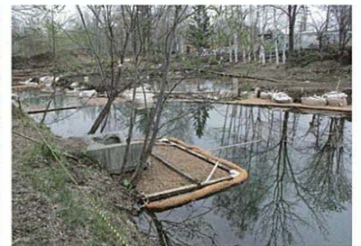
農業用溜池への油流出処理例
