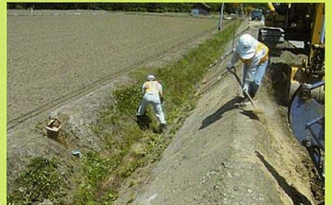
土水路の中に作動油がこぼれたのでオイルゲーターを使用し、早期処理を行い、油分の流出を防いだ。(作動油7L程度にオイルゲーターを4kg程度撒き処理)
